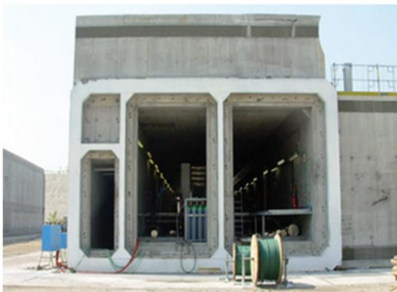
Concrete element with maintenance walkways and supply conduits: KELLER AG für Druckmesstechnik
